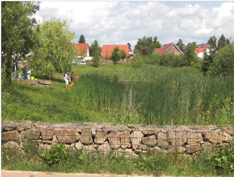
Abb. 30: Beispiel für einen naturnah gestalteten Regenwasserteich.
