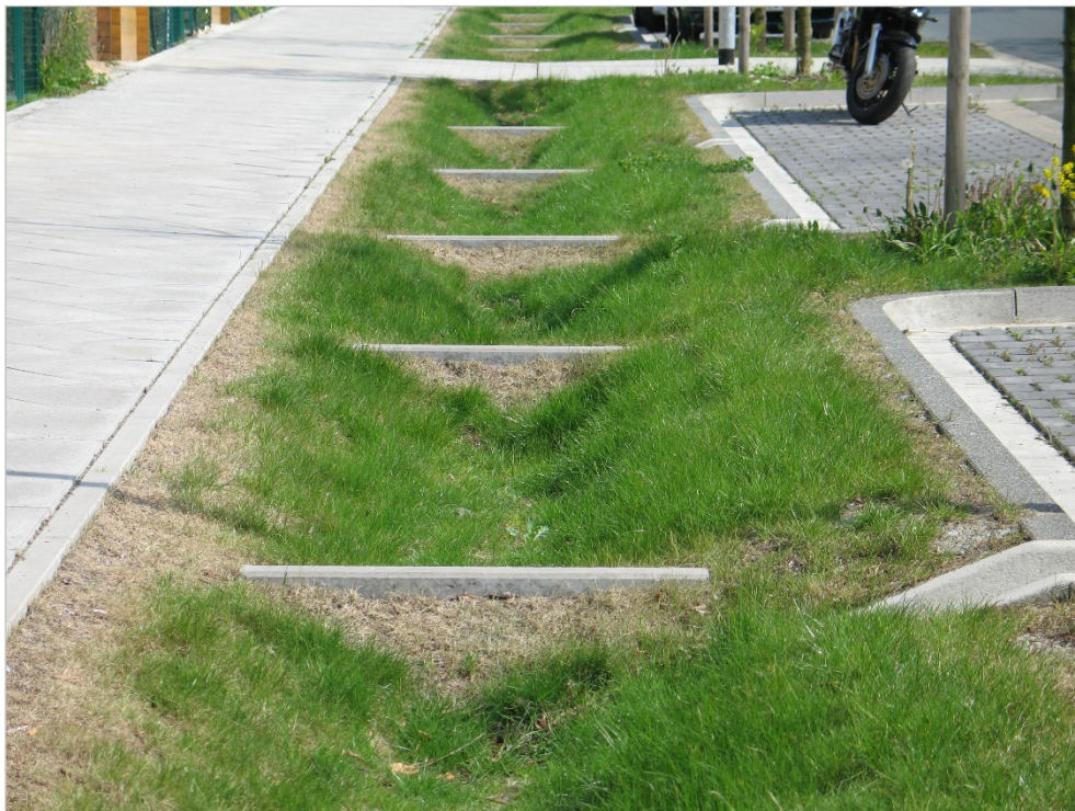
Abb. 27: Beispiel für eine Muldenversickerung mit Muldenunterbrechungen zum Ausgleich des Geländegefälles. Foto: I. Bolze (LBEG).
