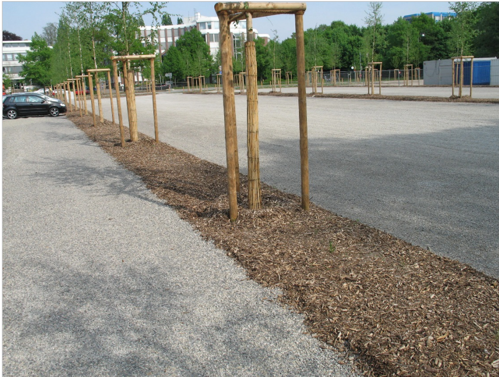
Abb. 38: Beispiel für die Entsiegelung von Parkplätzen.
