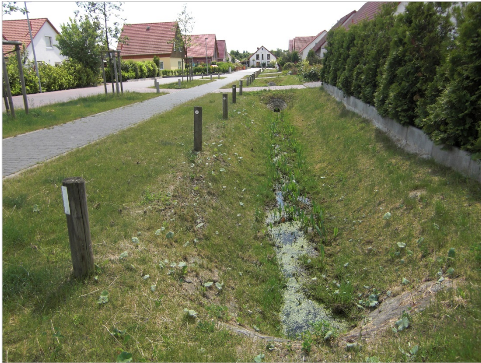
Abb. 31: Beispiel für die Zuführung des Niederschlagswassers von verschiedenen Flächen in einen offenen Graben. Foto: T. Nix (LBEG).
