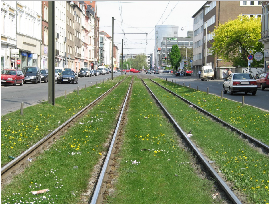
Abb. 39: Beispiel für die Teilentsiegelung von Gleisanlagen. Foto: I. Bolze (LBEG).
