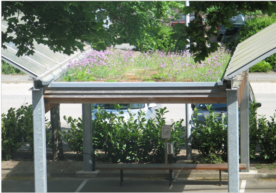
Abb. 32: Beispiel für eine extensive Dachbegrünung. Foto: I. Bolze (LBEG).
