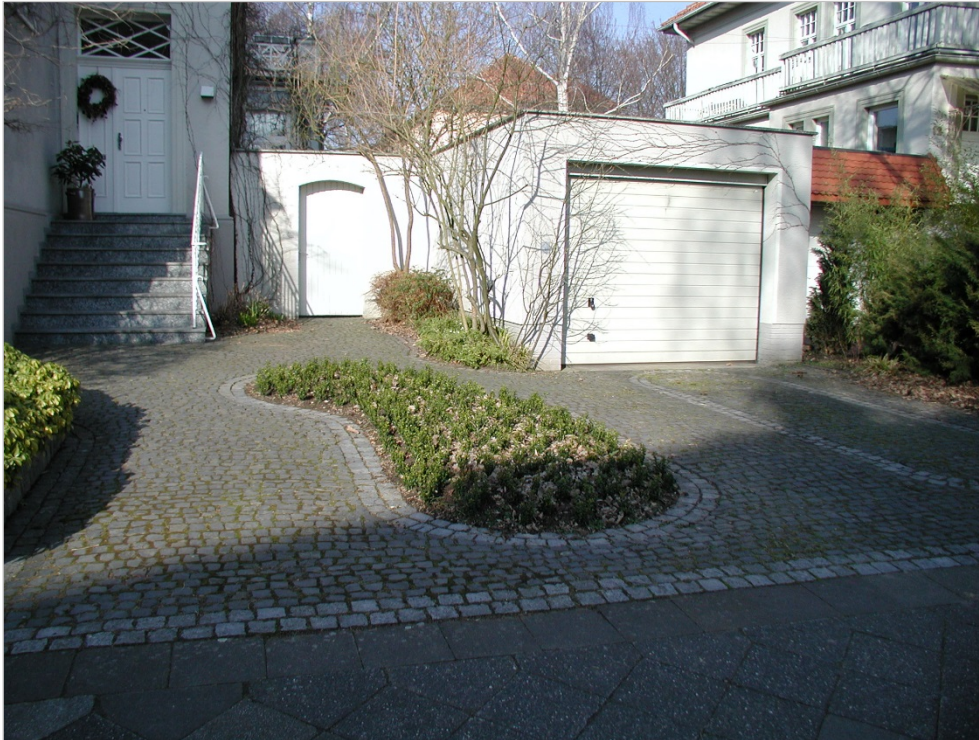
Abb. 35: Eingangs- und Einfahrtsbereich mit Natursteinpflaster und integriertem Beet. Foto: M. Gunreben (LBEG).
