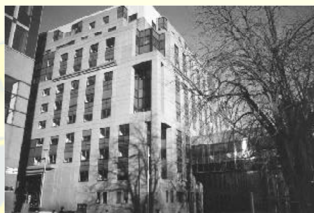
Das Gebäude des Ausschusses der Regionen (AdR) in der Rue Montoyer in Brüssel.
